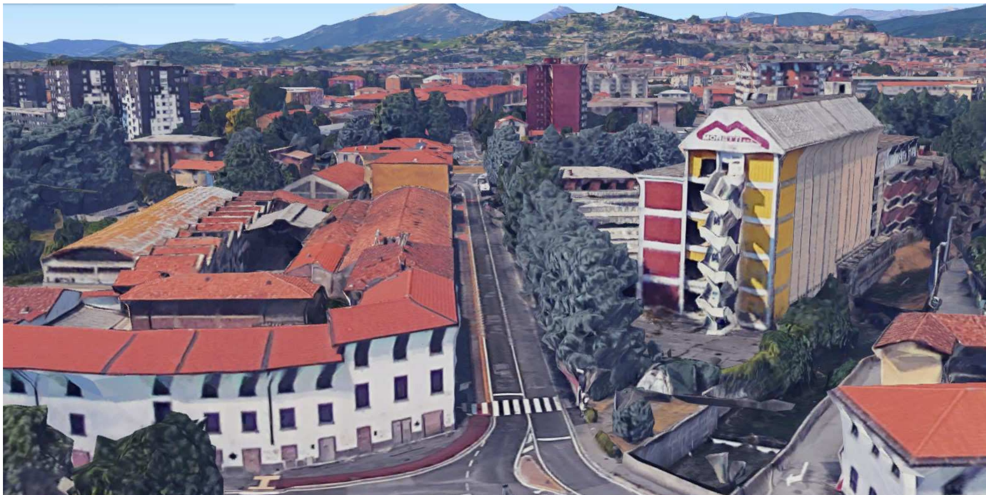
Figura 15: Vista aerea da SUD
